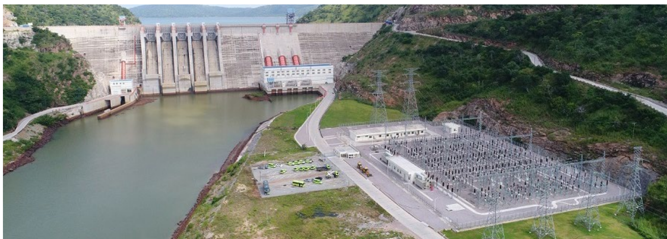
■ Presso la diga di Bui verrà costruito un impianto solare da 250 MW
