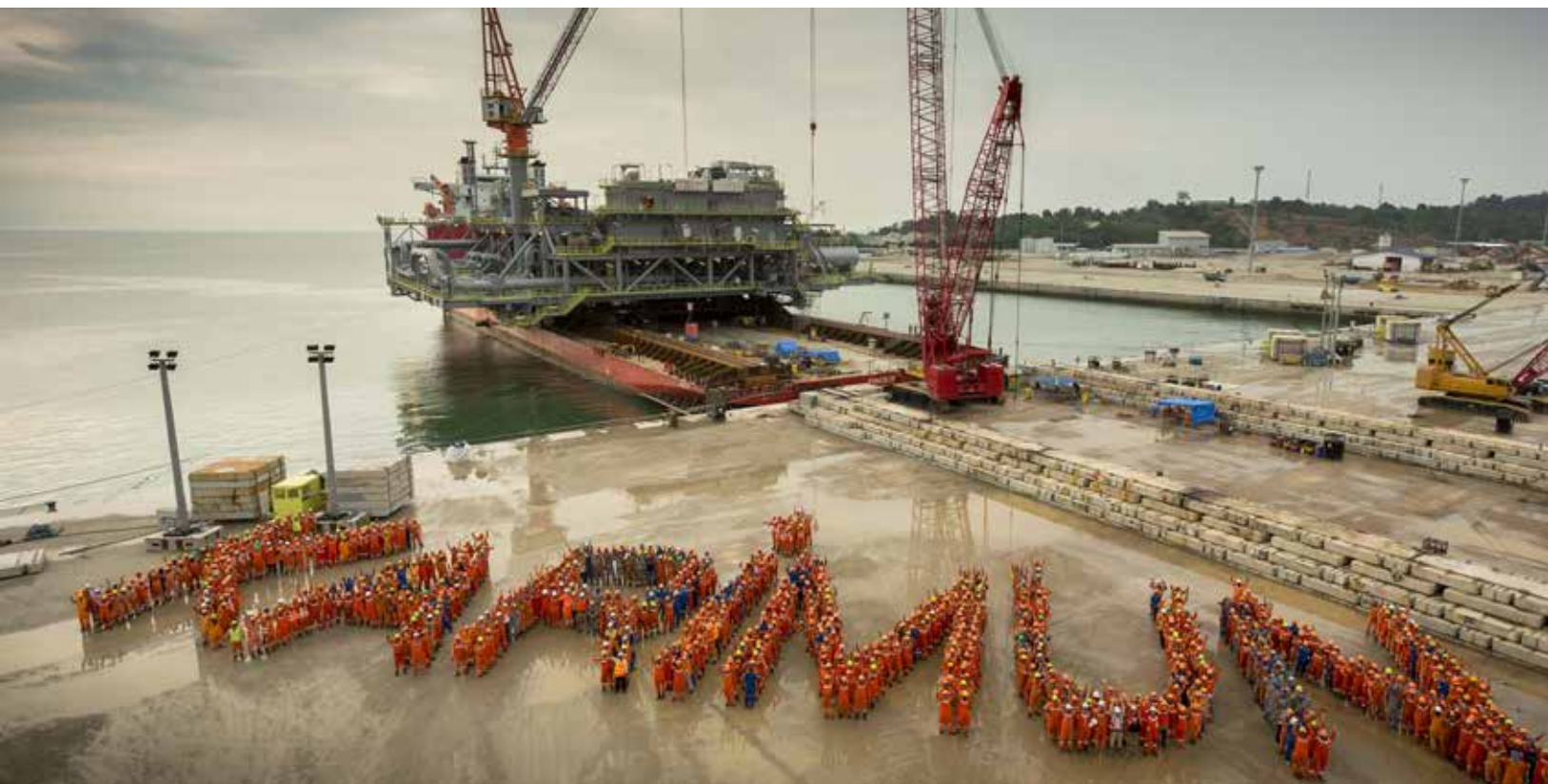
Le maestranze di Saipem sull'isola di Karimun (Indonesia) che hanno lavorato alla costruzione della piattaforma per l'estrazione offshore del gas e del gasdotto (a sinistra)
