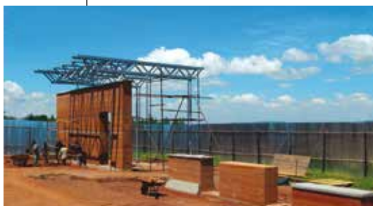
Renzo Piano e Gino Strada piantano l'albero simbolo dell'ospedale che l'architetto genovese ha progettato (a destra) a Entebbe, in Uganda. Sarà costruito (sopra) in terra pisè, una tecnica tradizionale che utilizza la terra cruda, garantendo un'inerzia termica che manterrà costanti la temperatura e l'umidità nell'edificio
