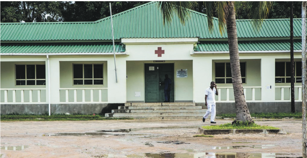
PALMA Al Centro sanitario di Palma, nella provincia di Cabo Delgado, sono stati rafforzati i servizi di emergenza infantile. In servizio dal 2013 il centro, ora ospedale rurale, è in grado di rispondere alle emergenze ostetriche e di diventare centro di riferimento dei casi complicati per il Nord della provincia.
