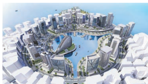
La nuova Marina a West Point in fase di realizzazione a Lagos
