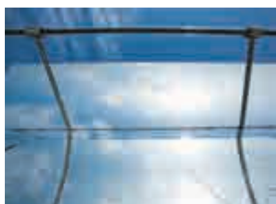
A Feira de Santana (Bahia) sarà installato il primo impianto solare al mondo di grandi dimensioni per la produzione diretta di vapore. In alto, un particolare dei tubi per la produzione di vapore
