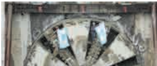
Uno dei giganteschi macchinari che Ghella impiega per scavare i tunnel sotterranei. Il costruttore romano vanta un'esperienza più che centenaria nella realizzazioni di grandi lavori di scavo
