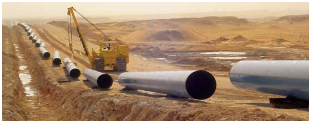
Una pipeline per il gas che Saipem sta costruendo in Arabia Saudita
