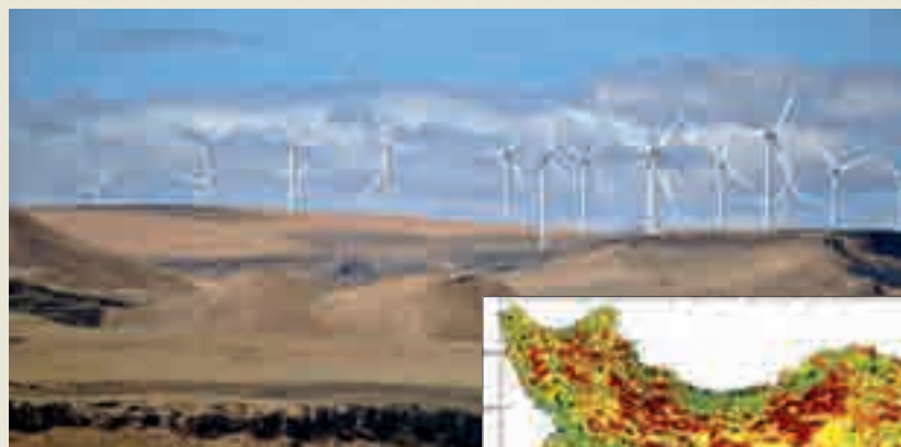
Le turbine eoliche della Manjil and Rudbar Wind Farm nella provincia di Gilan nel nord dell'Iran creata nel 2007. In quest'area dominata dal monte Alborz sono oltre 200 le turbine operative che nel 2015 hanno generato 300 milioni di kWh di energia. A destra la mappa del paese. Le zone più scure sono quelle a maggior capacità eolica
