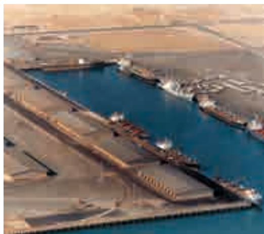
I bacini e le strutture portuali realizzate a Bandar Abbas da Condotte comprendono, fra l'altro, 8 chilometri di banchine ad alto fondale, due moli frangiflutti di 7 chilometri, 2.000 ettari di sistemazione a terra
