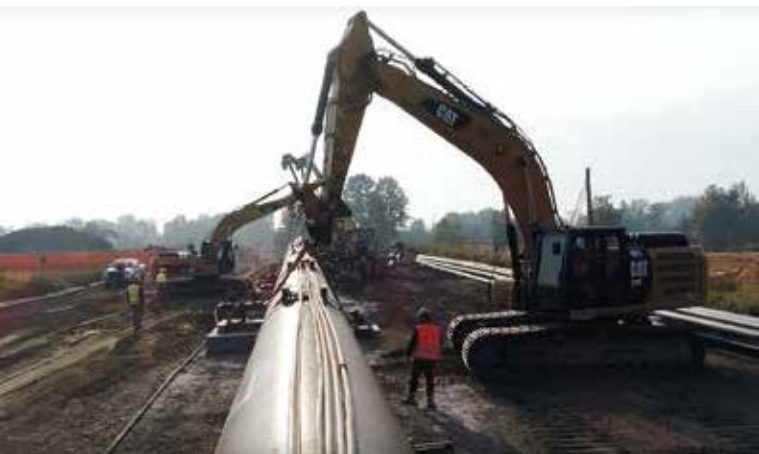
La posa di un gasdotto. Snam vanta la principale rete di distribuzione di gas in Europa, seconda solo a quella di Gazprom (Russia)
