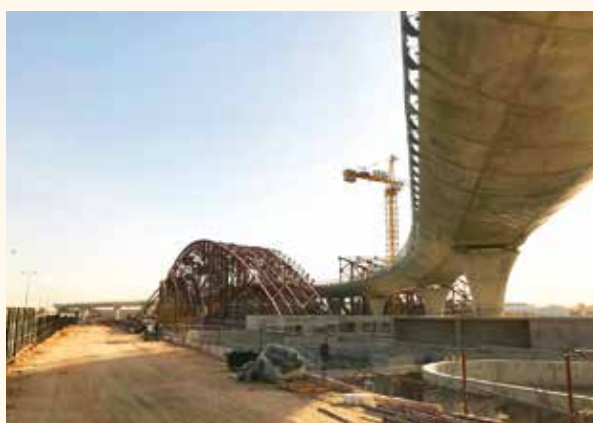
Qui e nella pagina accanto le due stazioni della metropolitana linea 3 di Riad, il cui project design è stato affidato alla OneWorks. Sopra, i lavori per la Western Station che sorgerà in mezzo a una piazza, destinata diventare un nuovo centro urbano. A sinistra, la Downtown Station, con il giardino situato a 40 metri sotto terra, illuminato dall'alto con un sistema di specchi
